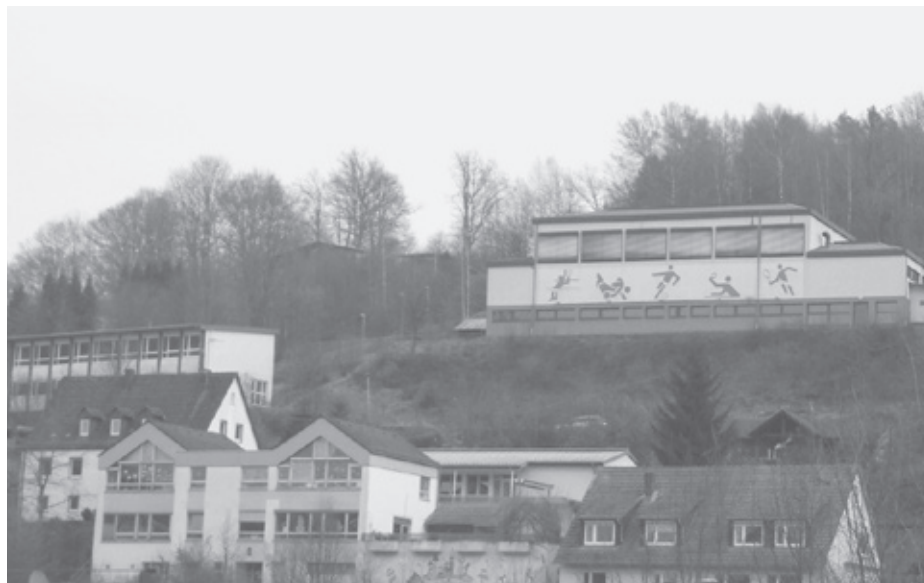
Kindergarten, Schule und Turnhalle auf der Kurzenrainhöhe („Kurzerahöö“)
